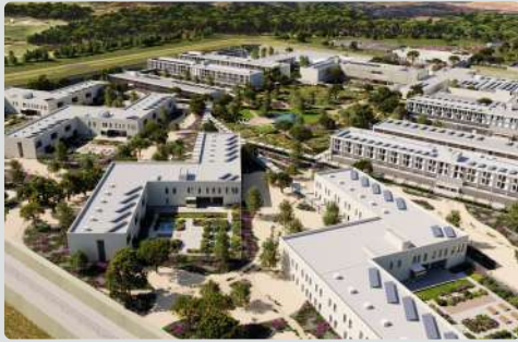
Hospital psiquiátrico penitenciario Siete Aguas, Valencia
