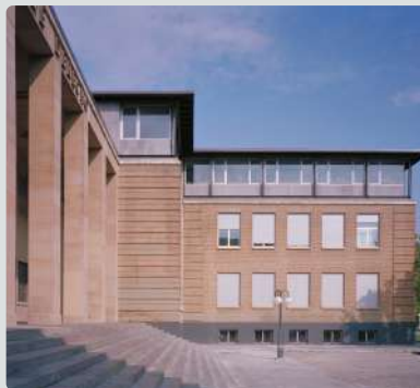
Ampliación de la Facultad de Derecho, Universidad de Zaragoza
