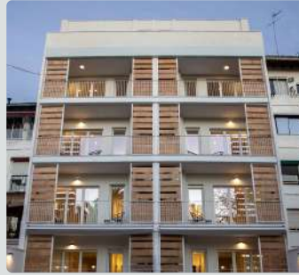
Rehabilitación Edificio Turia 63, Valencia
