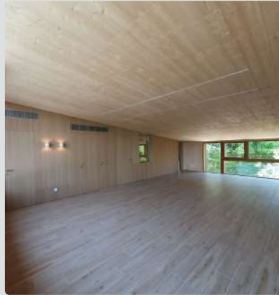
Vivienda unifamiliar aislada proyectada y ejecutada con estructura de madera, Bargas, Toledo
