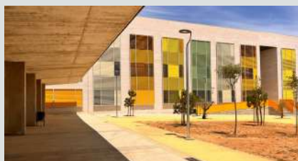
Edificio administrativo Junta de Andalucía, Córdoba
