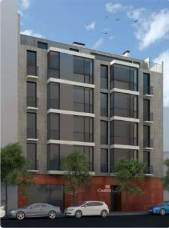
Edificio de viviendas Marques de Cruilles, Valencia
