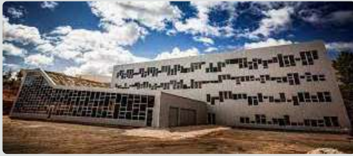
Edificio I+D+I Campus Duques de Soria, Soria
