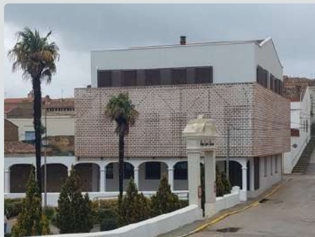
Rehabilitación Centro de Salud, Sinarcas, Valencia
