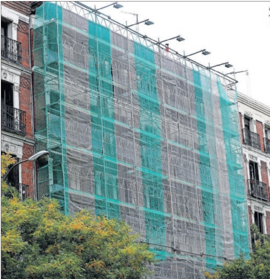
Obras para la rehabilitación de un edificio en el centro de Madrid. / JAIME VILLANUEVA
